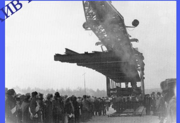
Демонстрируется работа путеукладчика на станции Таксимо. На вездостроичной базе в Северобайкальске сшиваются клетки железнодорожного пути, п. Таксимо, 25 декабря 1983 г.
