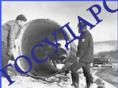
БAM. Подготовка к укладке гофрированных труб. 1975 г.
