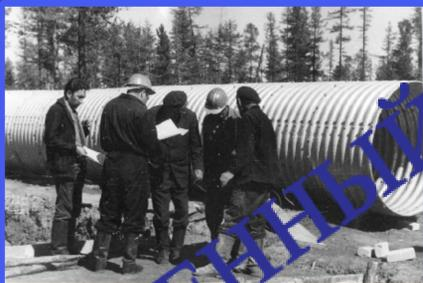
Сборные металлические трубы вместо бетонных - новшество при строительстве БАМа. Бригада Бурятии впервые на БАМе. Участок № 11-го тоннельного отряда «автономельстроя». Август 1974 г.
