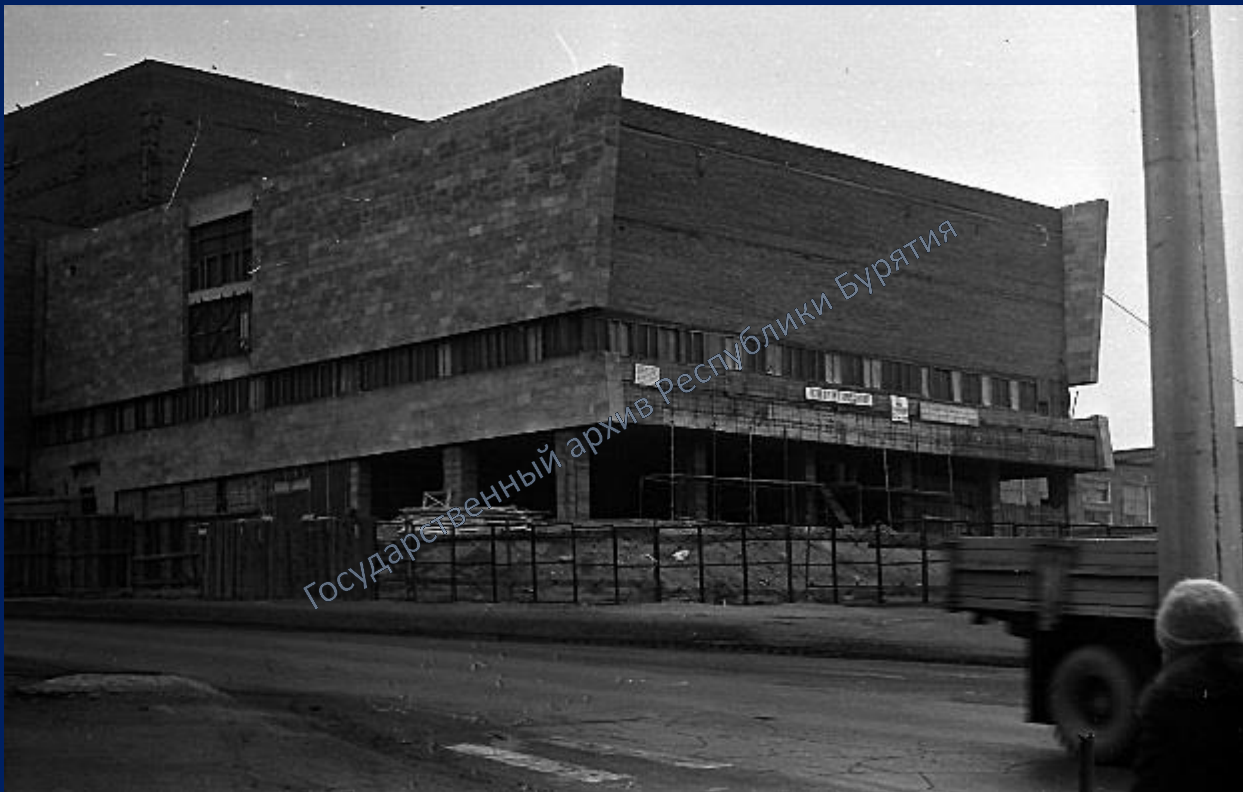
Строительство здания Бурятского драматического театра. Март 1980 г.
