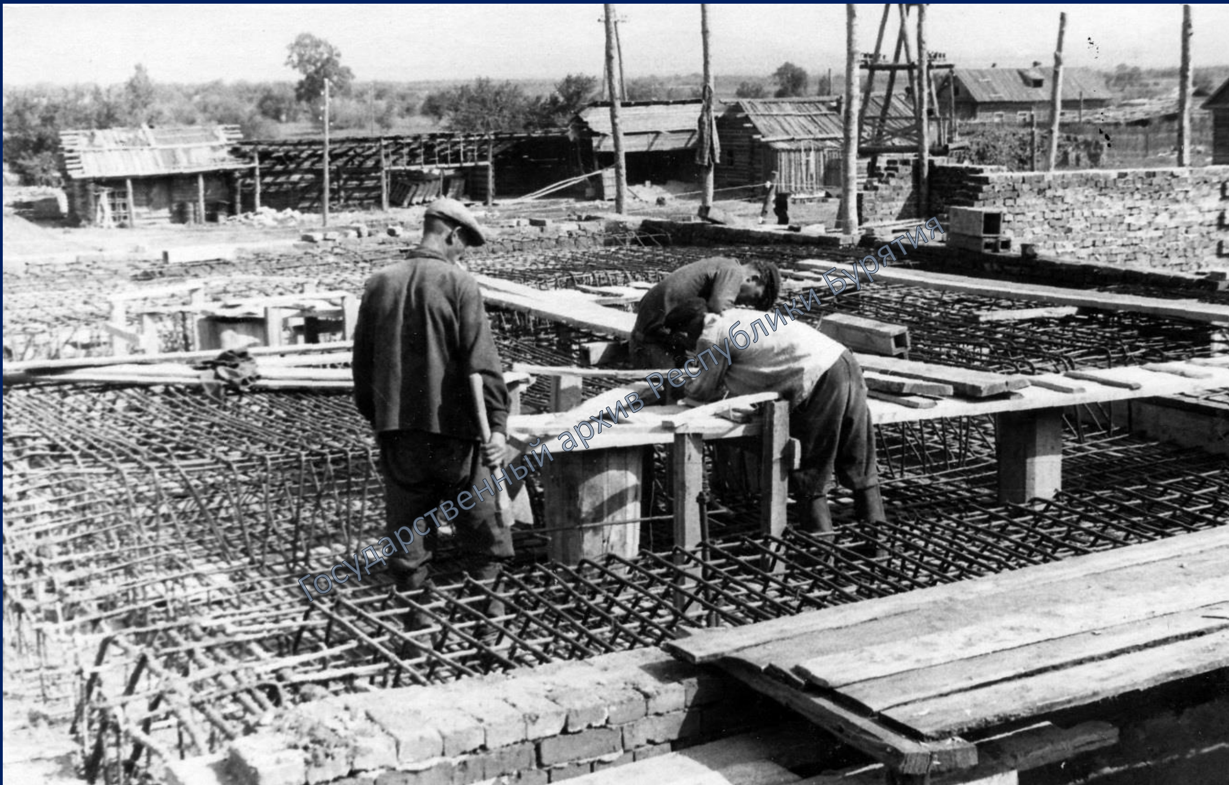
Строительство Тохойской ГЭС. [1955 г.]. Фотофонд ГАРБ
